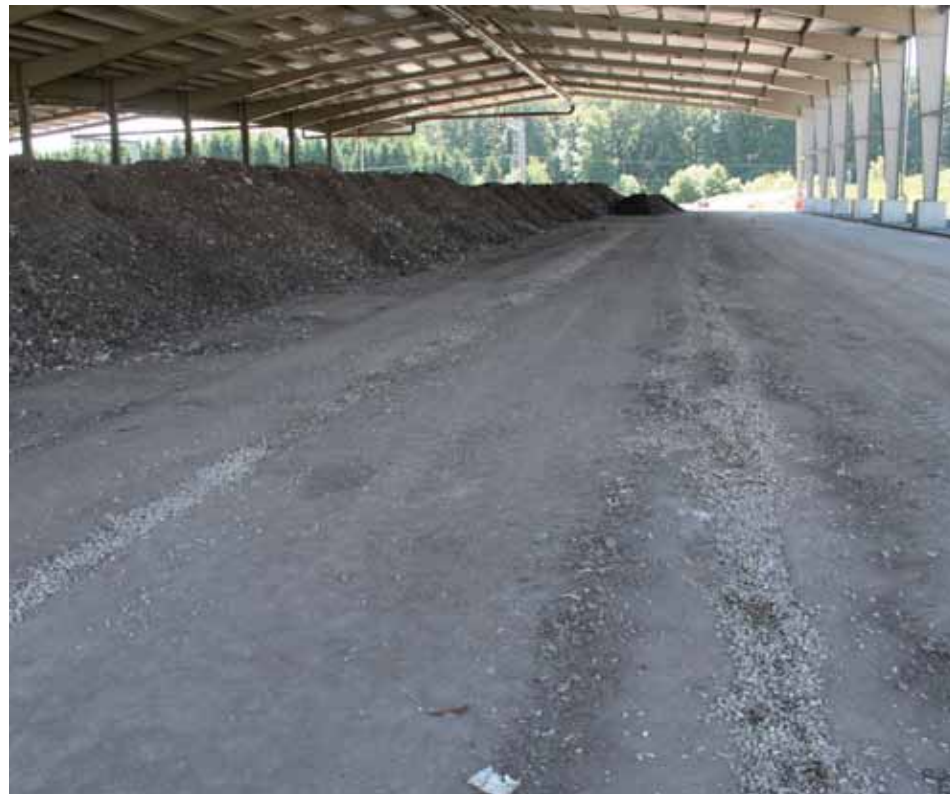
Blick in die Rottehalle
