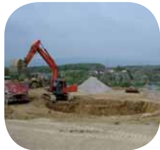
Rundbecken und Prallmauer
