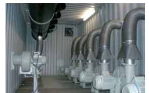
Vormontierter Lüftercontainer
