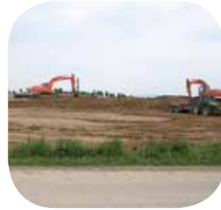
30.000m 3 Erdbau sind zu bewältigen
