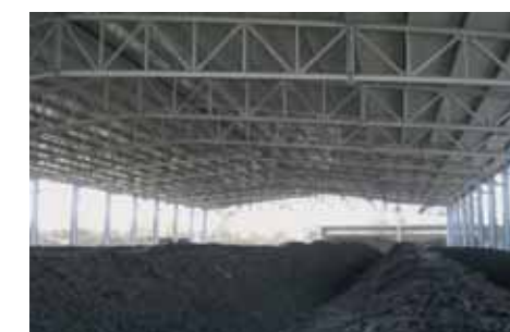
Blick in die Rottehalle
