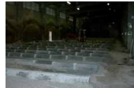
Verlegung der Belüftungsrohre
