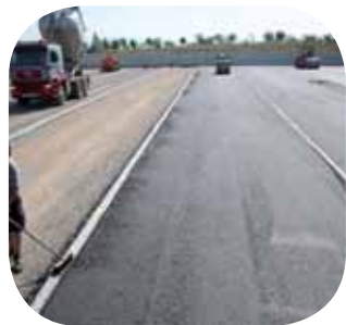
Tragschicht und Dichtasphalt werden...
