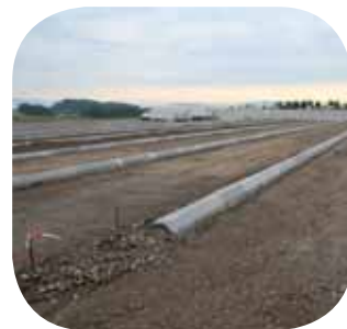
...die 8 Belüftungsstränge verlegt und die Fläche kann asphaltiert werden
