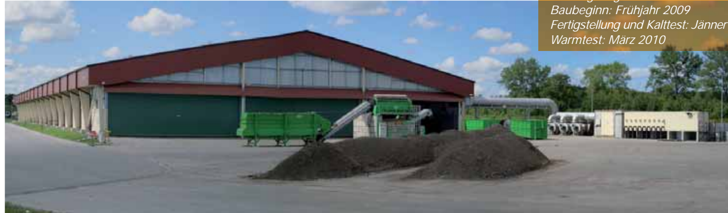
Rottehalle mit Siebstation, Nachrotte und Biofilter
