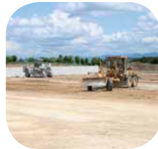
Unerwartete Schwierigkeiten – der Boden muss mit Kalk stabilisiert werden
