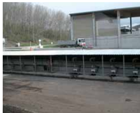
Lüfterstation MBA Anlage
