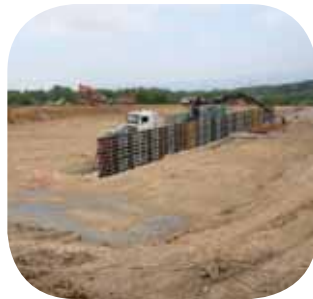
...die Anlage nimmt „Form“ an
